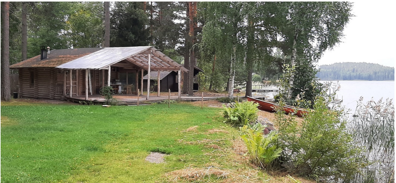
Kaislarannan piha-alue ja purettava lomarakennus. Taustalla rannan puolella on purettava aitta.
